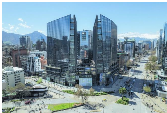
Foto 6: Fachada Mercado Urbano Tobalaba
